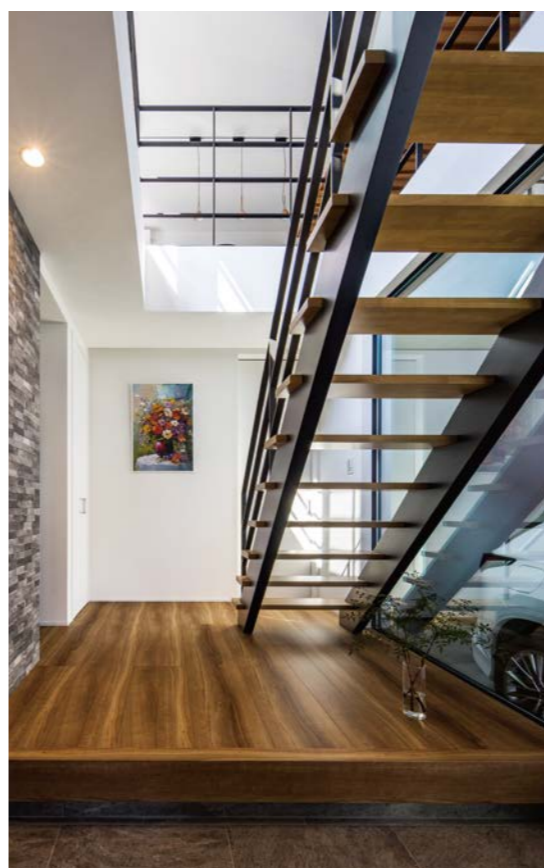
1階玄関から見た階段室と吹抜。階段には、光も視界も遮らないスケルトン式を採用
